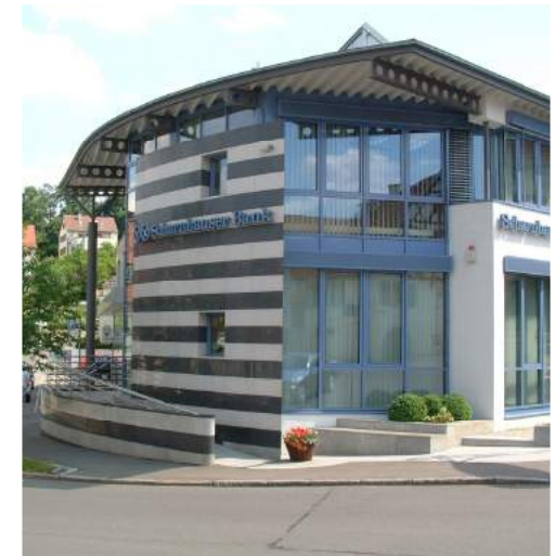
Die neue Scharnhauser Bank
