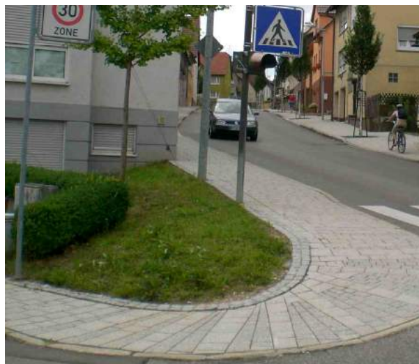
Durch die Verengung der Fahrbahn wird Raum für Fußgänger und Grün geschaffen.
