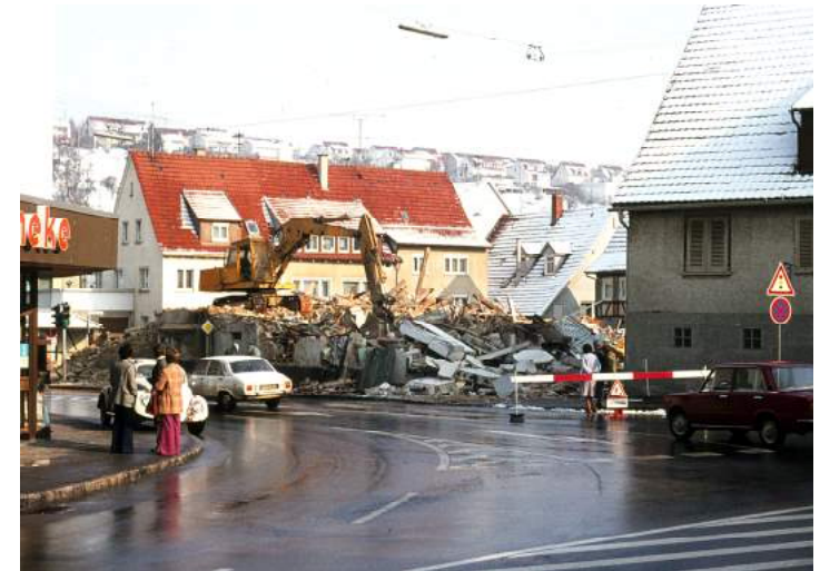
Ende der 1970er Jahre müssen die Gebäude an der Rüter Straße der neuen Straßenführung weichen.
