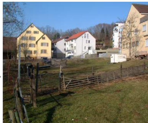
Nach dem Abbruch ist der Blick vom Körschweg zur Mühle frei
