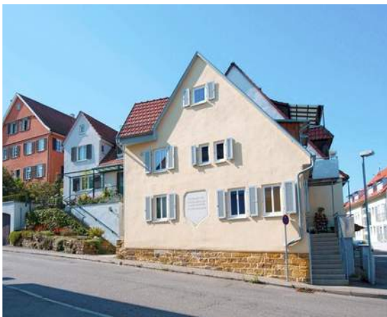
Das sanierte Gebäude Nürtinger Straße 4
