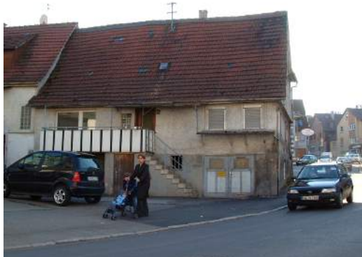
Untergenutztes Gebäude in der Ruiter Straße
