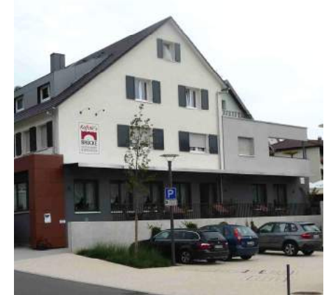
Nellinger Straße 18 ("Brücke")
