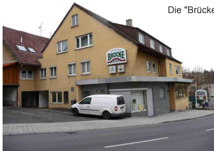
Nordseite an der Nellinger Straße
