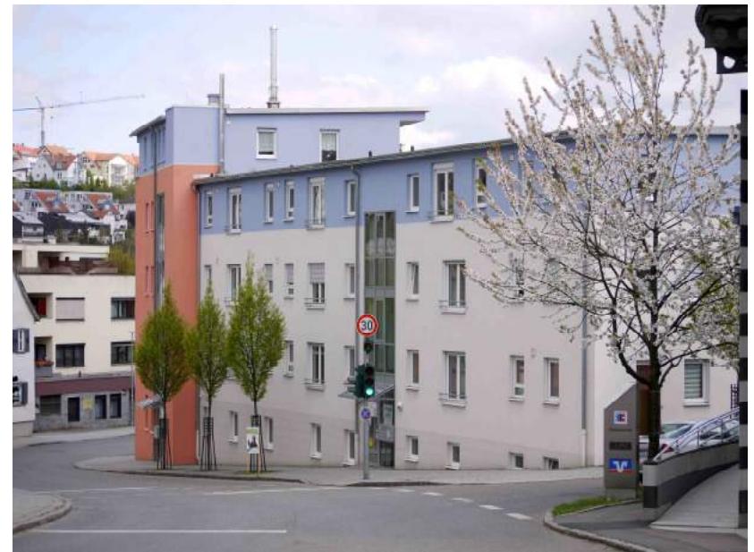
Neubau Ruiter Straße 9 + 7
