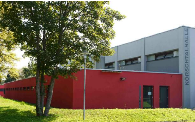
Die 2013 sanierte Körchtalhalle
